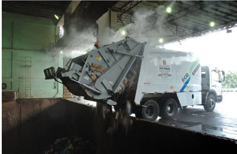
Figura 2: Transferência dos resíduos sólidos do caminhão coletor para fosso de recepção
