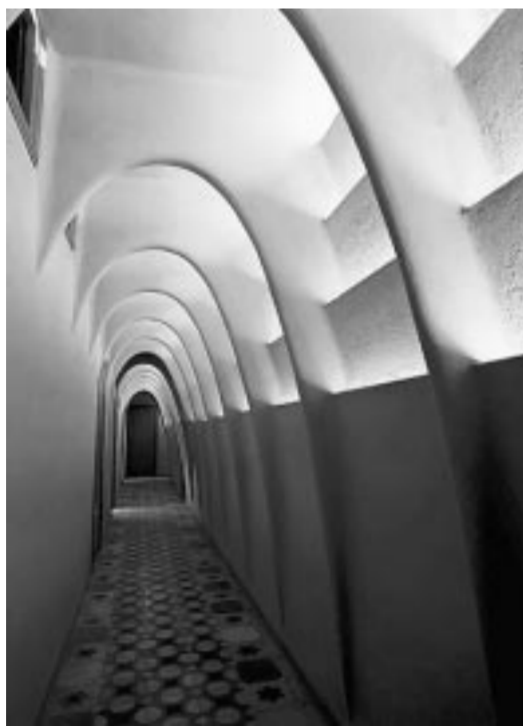
Arcos da Casa Batlló, uma das impressionantes construções do arquiteto catalão
