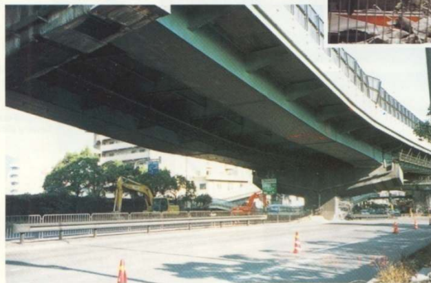
橋脚の崩壊により座屈した鋼製桁。
