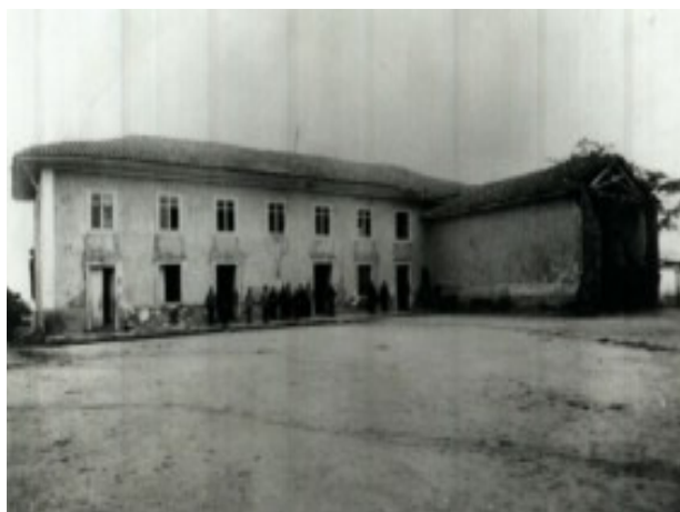
Fachada do antigo solar, sede da Fazenda de Santana. Em ruínas, a Capela de Santana. (s/d) 3
