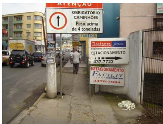
Figura 04 – Placa indicando estacionamento implantada no passeio.
