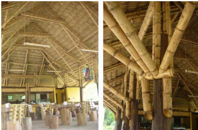
Figura 8: Vista interna da cobertura, detalhes do encontro entre peças estruturais.
