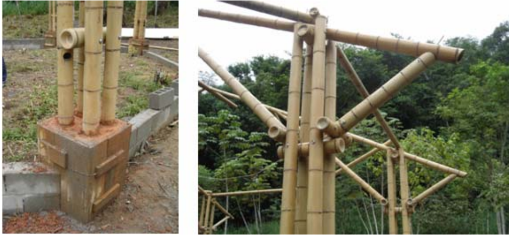
Figura 6: a) Encontro dos pilares com a fundação b) Detalhe do pórtico na Sede da IBIOSFERA. Fonte: Marquez, 2007
