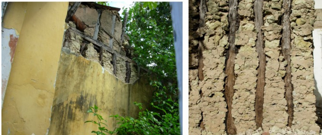
Figura 2 - Enxaiméis preenchidos com pedra calcária na Paraíba – fotos do autor
