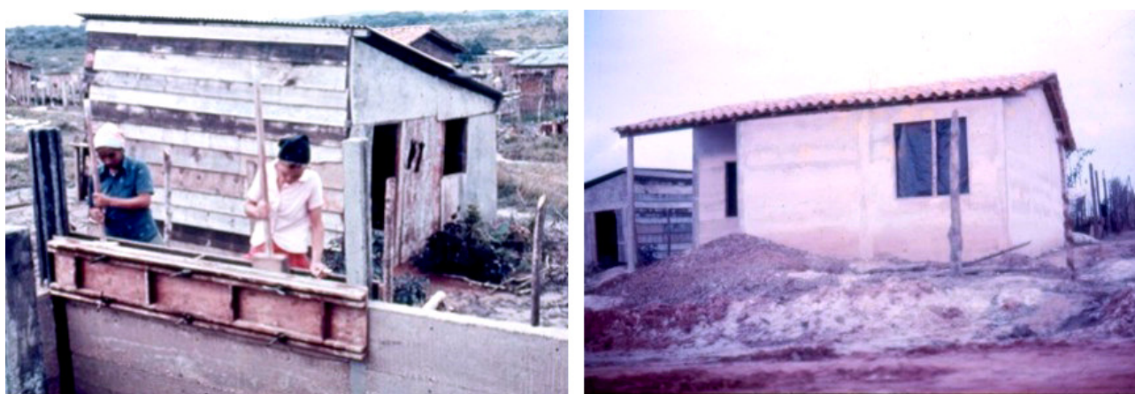
Figura 4 – Construções de solo-cimento em Camaçari - BA, adaptação de técnica tradicional – fotos Projeto THABA/CEPED 1978
