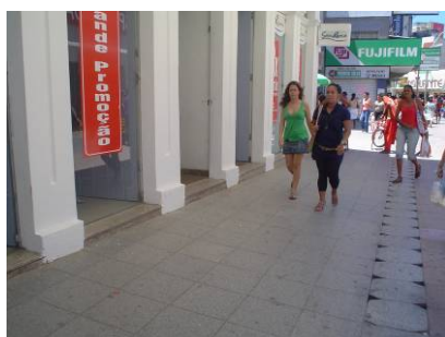
Figura 4: Pisos com textura característica de piso tátil de alerta, dispostos de forma inadequada, passível de confundir o deficiente visual.
