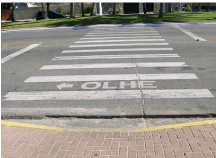
Figura 19: Rebaixamento de guia seguido de faixa de pedestre onde na extremidade oposta não existe a rampa para acessar o passeio.
