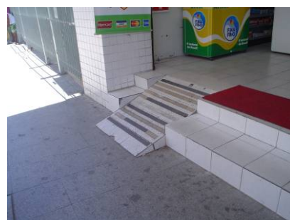
Figura 4: Pisos com textura característica de piso tátil de alerta, dispostos de forma inadequada, passível de confundir o deficiente visual.
