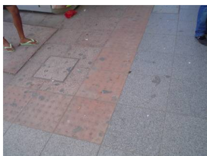
Figura 4: Pisos com textura característica de piso tátil de alerta, dispostos de forma inadequada, passível de confundir o deficiente visual.
