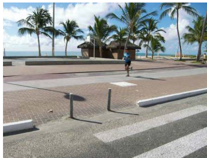
Figura 19: Rebaixamento de guia seguido de faixa de pedestre onde na extremidade oposta não existe a rampa para acessar o passeio.
