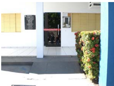
Figura 11 - Rampa acesso Fonte: Carignani (2008)
