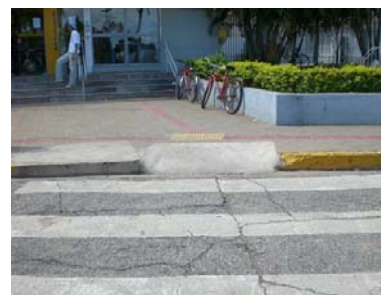
Figura 03-Rebaixamento da calçada
