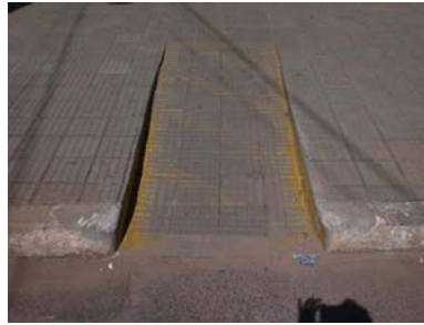
Figura 05–Rebaixamento de calçada
