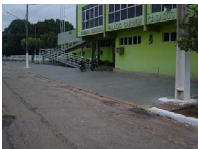
Figura 14 - Rampa acesso Fonte: Carignani (2008)
