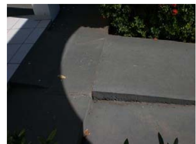
Figura 10 – Rampa de acesso
