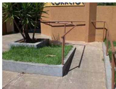
Figura 27 – Rampa acesso Correios
