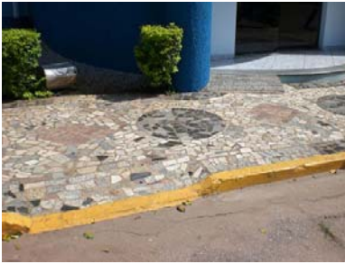
Figura 04–Rebaixamento de calçada calçada Fonte: Carignani (2008)
