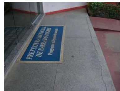
Figura 38- Rampa acesso Prefeitura
