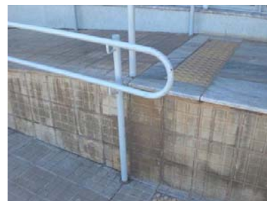
Figura 25 – Corrimão rampa banco
