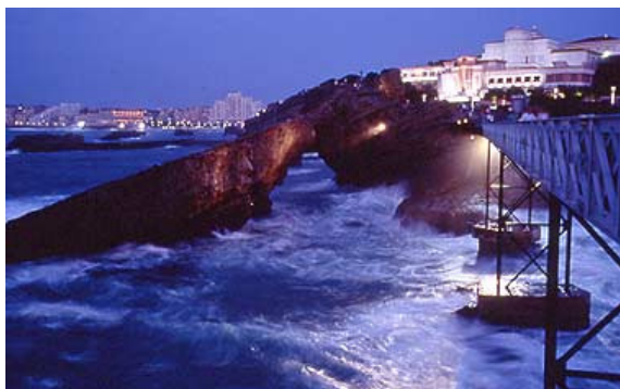
Foto 09: Intervenção de iluminação na paisagem marítima da vila de Biarritz.
