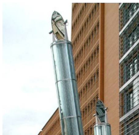
Figura 07: Perspectiva de pavimento tipo - Detalhe de tubulação para iluminação natural em átrio. Fonte: Moisinho, 2002
