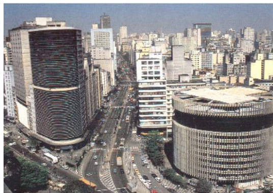
Figura 03: Vista do Edifício Montreal e acessos Fonte: Arquivo do edifício Montreal
