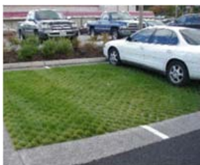
F09: Pavimento Permeável [Fonte: Green Infrastructure]
