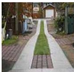
F10: Pavimento Permeável [Fonte: Green Infrastructure]
