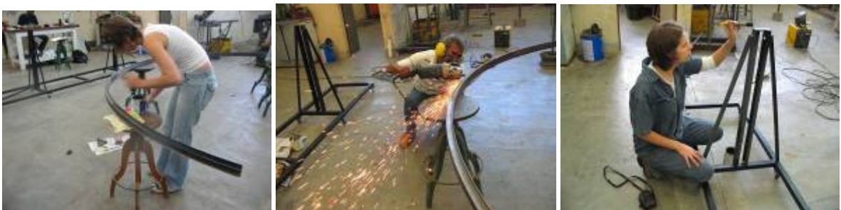
Figura 7 - Pintura e montagem da estrutura (fotos: D. Duarte)
