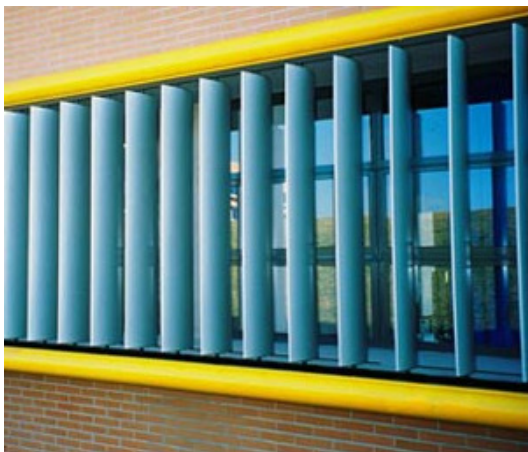
Figura 6 – Brises verticais numa janela. / Fonte: http://www.refax.com.br/brise/galeriadefotos_ter.html
