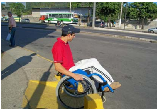
Ilustração 03: Aplicação do método Passeio Acompanhado com portador de restrição físico motora: rampas com inclinação inadequada. Fonte: VASCONCELLOS, 2006
