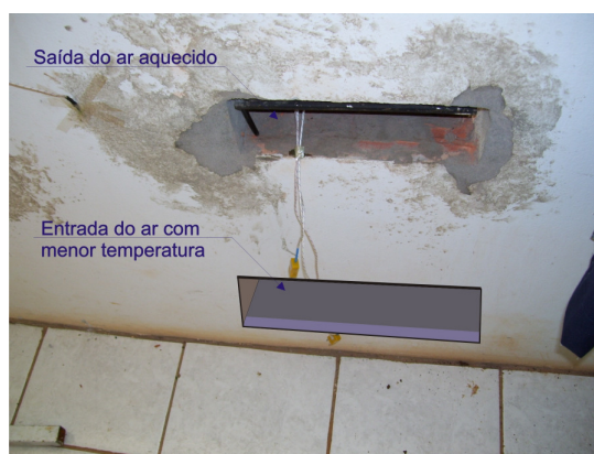
Figura 3 – Transformação do processo de aquecimento para ciclo fechado – esquema de funcionamento
