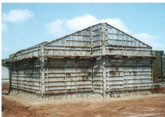
Figura 1. Visão geral das fôrmas das vedações montadas. Analândia-SP.
