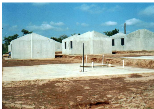
Figura 2. Em primeiro plano, fundação em radier; atrás habitações com os painéis concluídos. Analândia-SP.
