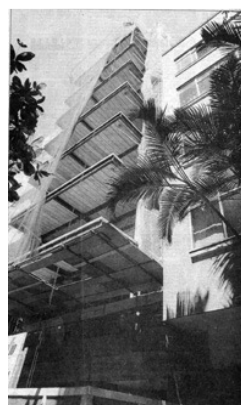
Fig.:3 - prédio da rua General Artigas no Leblon, apresentando acréscimo de varanda / Fonte: CASEMIRO, L. Garantindo Área Externa. O Globo, Rio de Janeiro, Caderno Morar Bem, p.3, 25 de março de 2007. Fotógrafo André Coelho.
