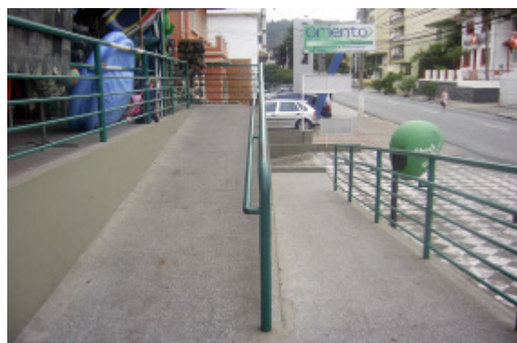
Foto 5. Rampa adequada com corrimão.
