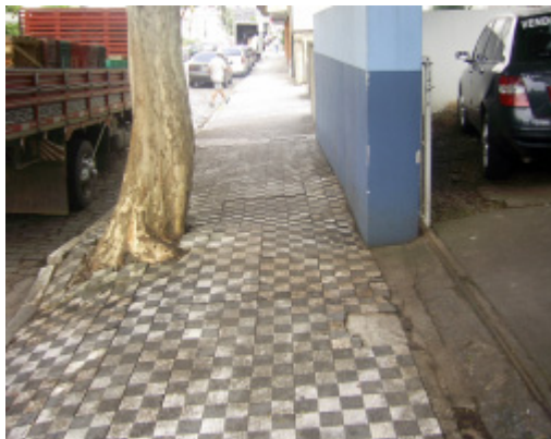
Foto 7. Arborização inadequada obstruindo o passeio na Rua Getúlio Vargas
