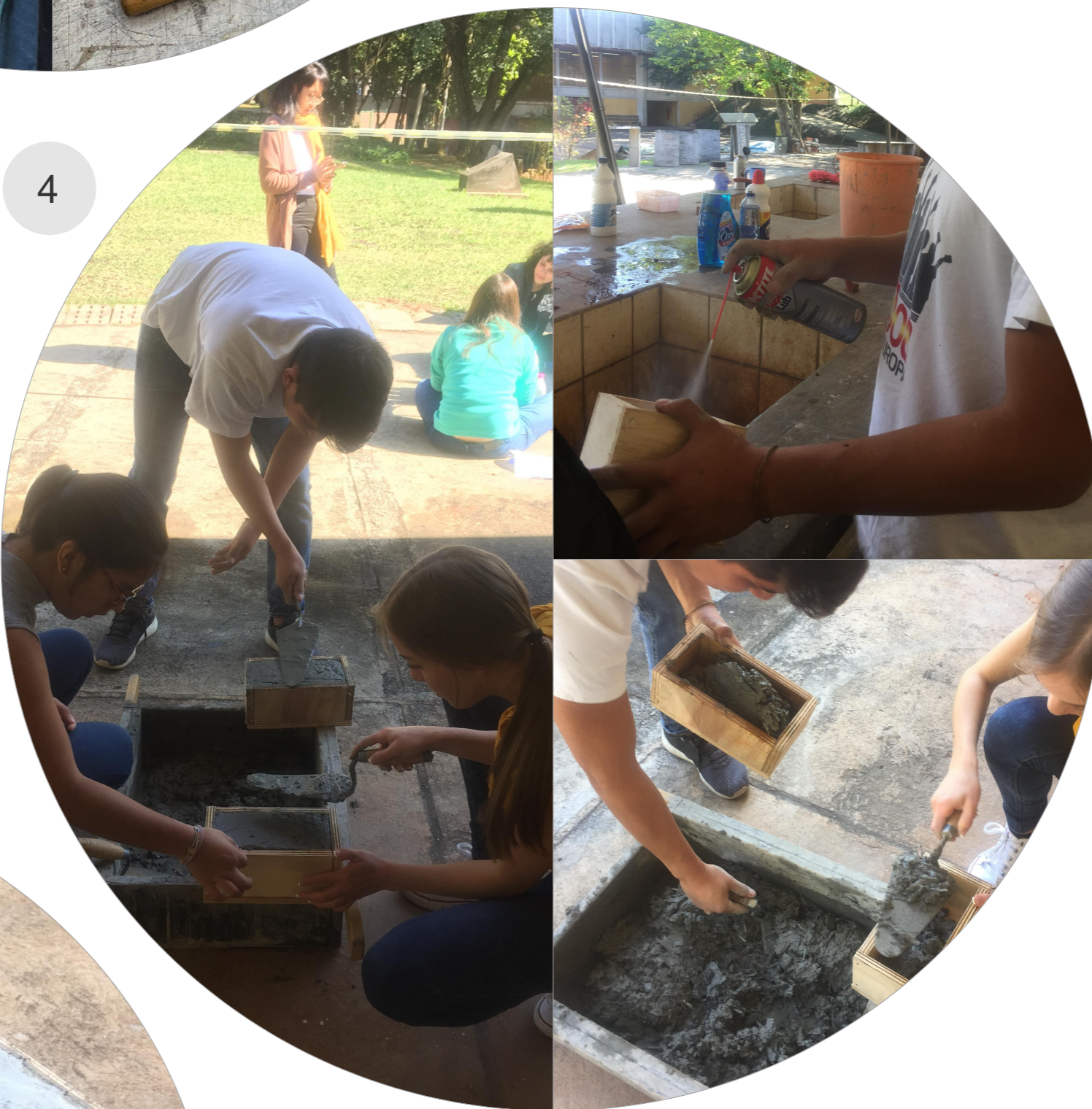
4. colocação da mixtura na cofragem
