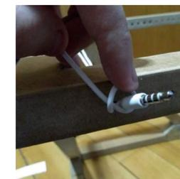
7. Retorne a ponta do cabo por dentro do primeiro furo, junto com o conector. Faça o arremate com um nó simples em torno da base do conector.
