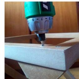
7. Com os quadros e os apoios fixados, o banco começa a tomar forma. Para torná-lo mais resistente, parafuse cada apoio na base novamente, mas agora no sentido vertical. Utilize parafusos de 35 mm para o furo mais externo e 50 mm para o mais interno.
