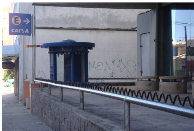
Fig. 8: Grade ondulada sobre estrutura tubular obsta seu uso como encosto ou assento, em agência central da Caixa Econômica Federal (Patrícia Alonso, 2010).
